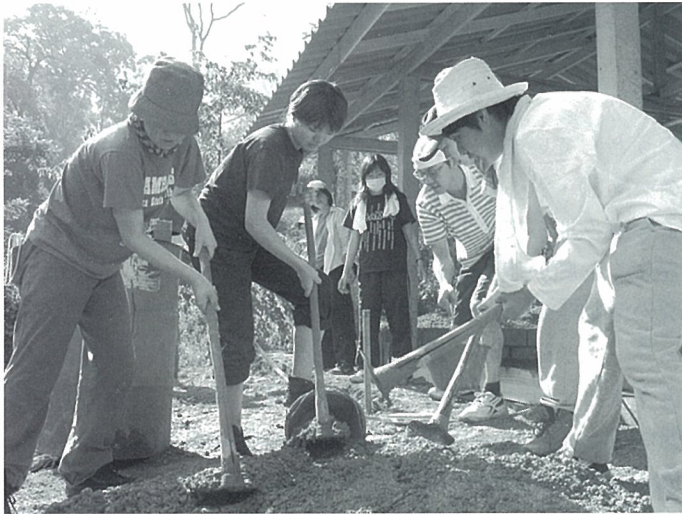
2005年3月 チェンライ県アカ族ボン村 学部生による教会堂建設作業
