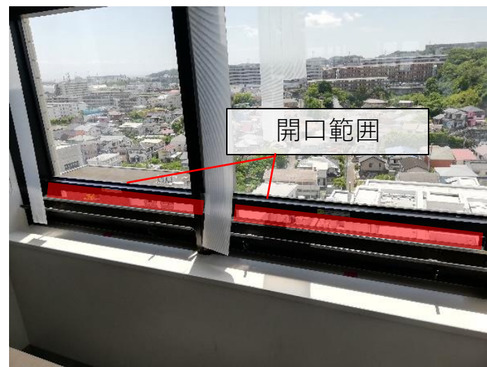
開口部（窓）の開口状態
