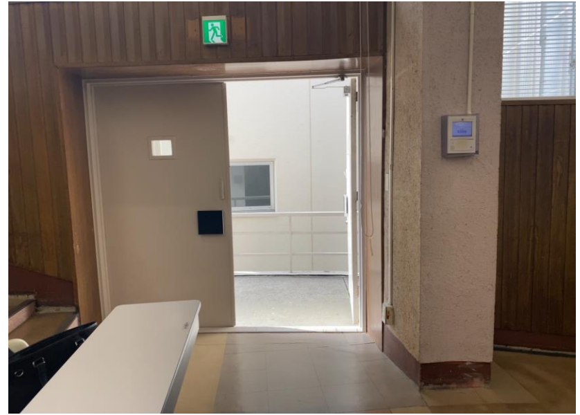
開口部（ドア）の開口状態
